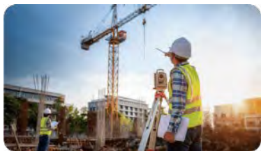
Obras de construcción
